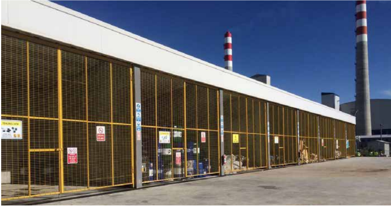
Atık kodlarına göre ayrılmış 8 odalı atık sahası
